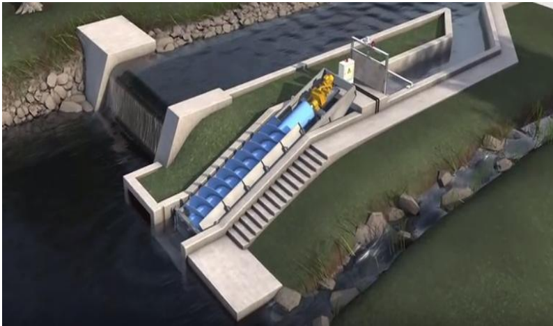
Σχήμα 3.11 Τυπική εγκατάσταση υδροστροβίλου τύπου Αρχιμήδους.
